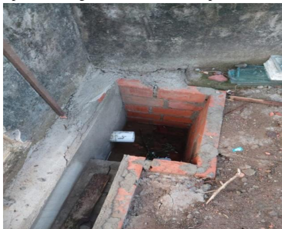
Gambar 1 Kondisi Eksisting Saluran Air
